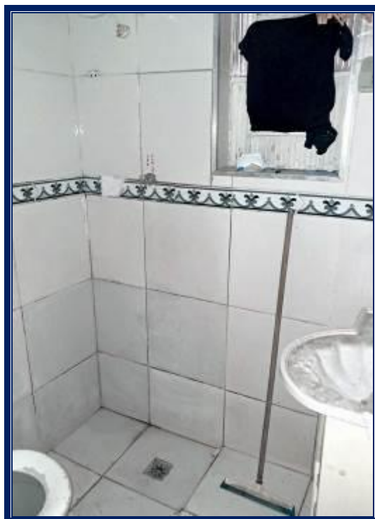
Casa 3 – Térreo: Banheiro.
