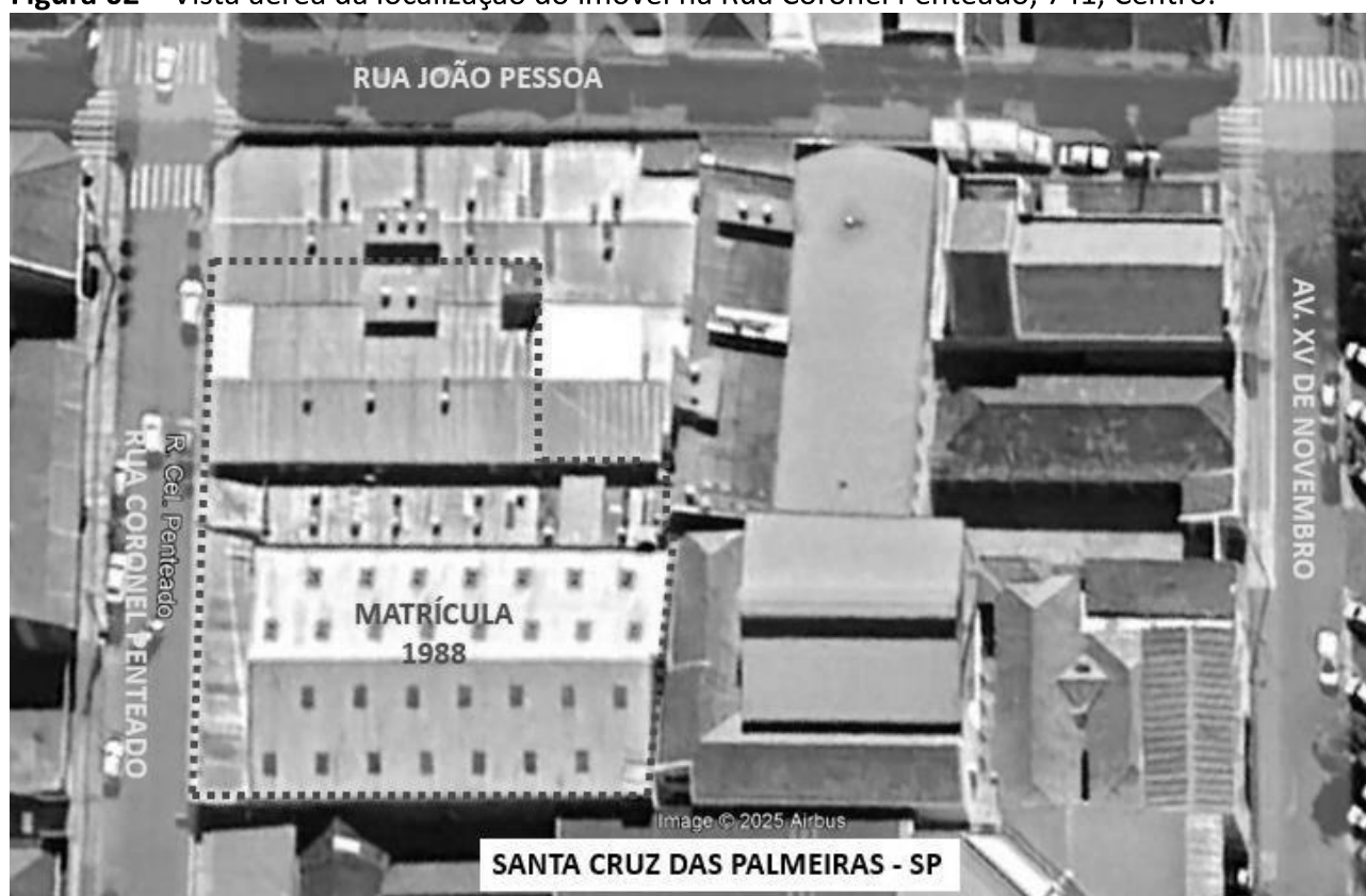
Figura 02 – Vista aérea da localização do imóvel na Rua Coronel Penteado, 741, Centro.
