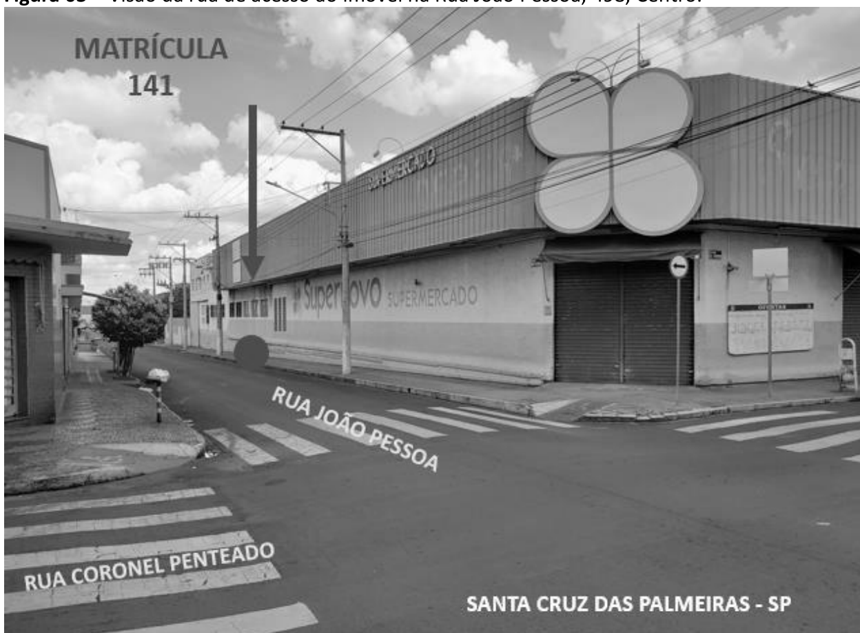
Figura 03 – Visão da rua de acesso ao imóvel na Rua João Pessoa, 498, Centro.
