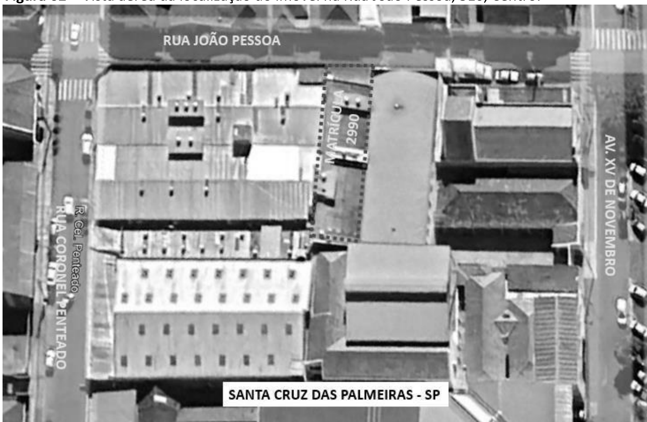
Figura 02 – Vista aérea da localização do imóvel na Rua João Pessoa, 510, Centro.
