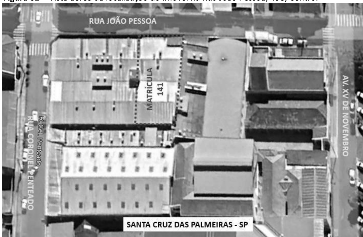
Figura 02 – Vista aérea da localização do imóvel na Rua João Pessoa, 498, Centro.
