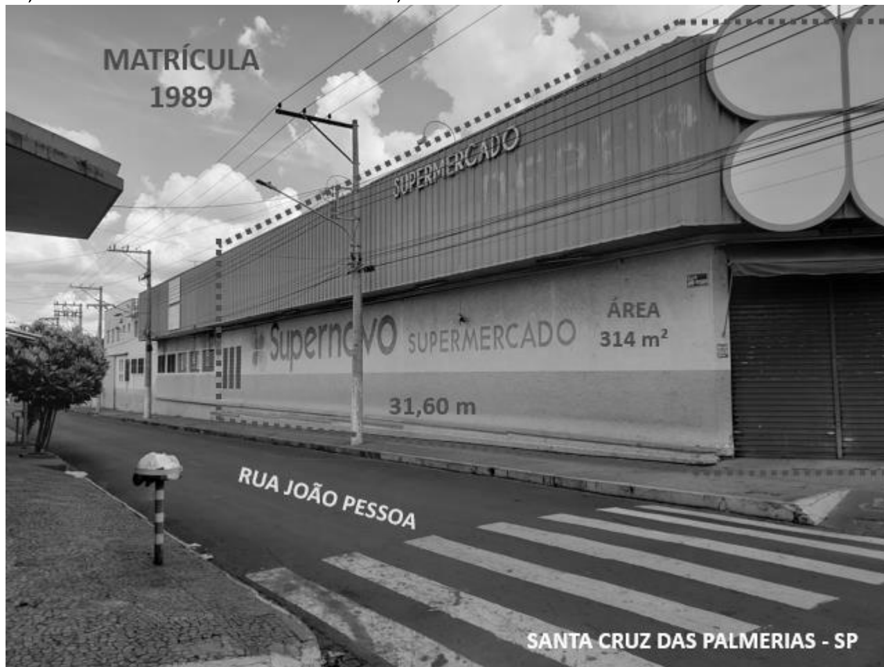
Figura 04 – Visão Lateral do imóvel localizado na esquina da Rua Coronel Penteado, 703, com a Rua João Pessoa, no Centro da cidade. Comprimento (frente ao fundo) do Lado Esquerdo medindo 31,60 metros e do Lado Direito medindo 31,20 metros.
