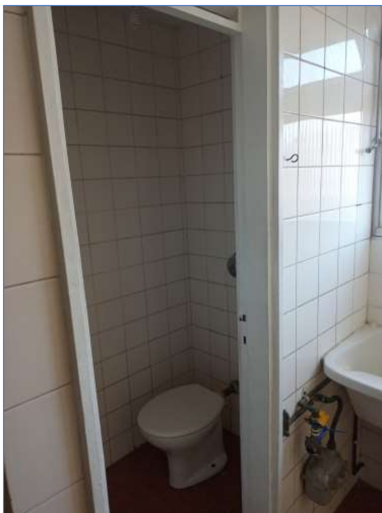
Foto de nº 25- Banheiro serviço.
