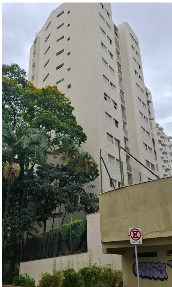
Foto 02 – fachada lateral e fundos
